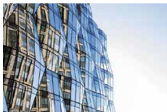
БЦ «Искра Парк» GBA: 76 915 кв.м. NRA: 58 297 кв.м. BREEAM
